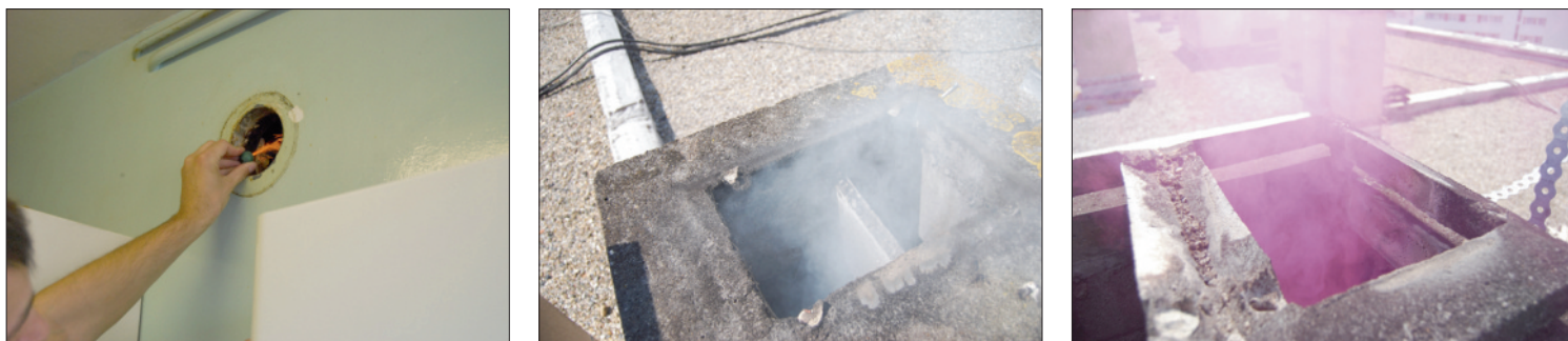
Contrôle de vacuité et de repérage des conduits par test fumigène.
