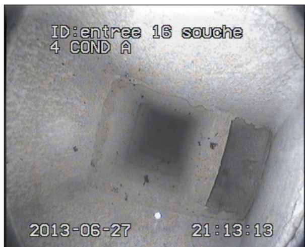
Contrôle des conduits existants par passage caméra
