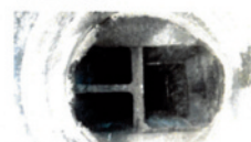
Débouché des conduits
