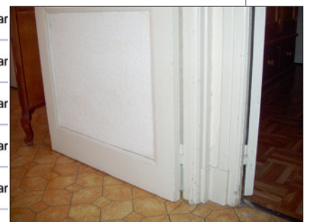
Contrôle visuel du détalonnage de porte
