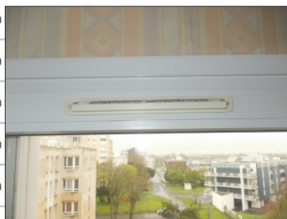
Entrée d'air existante
